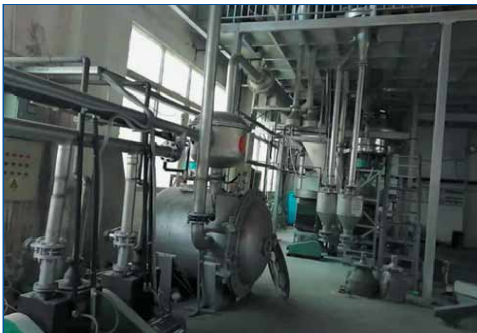
Рис. 2. Оборудование для подготовки металлического порошка из припоя
